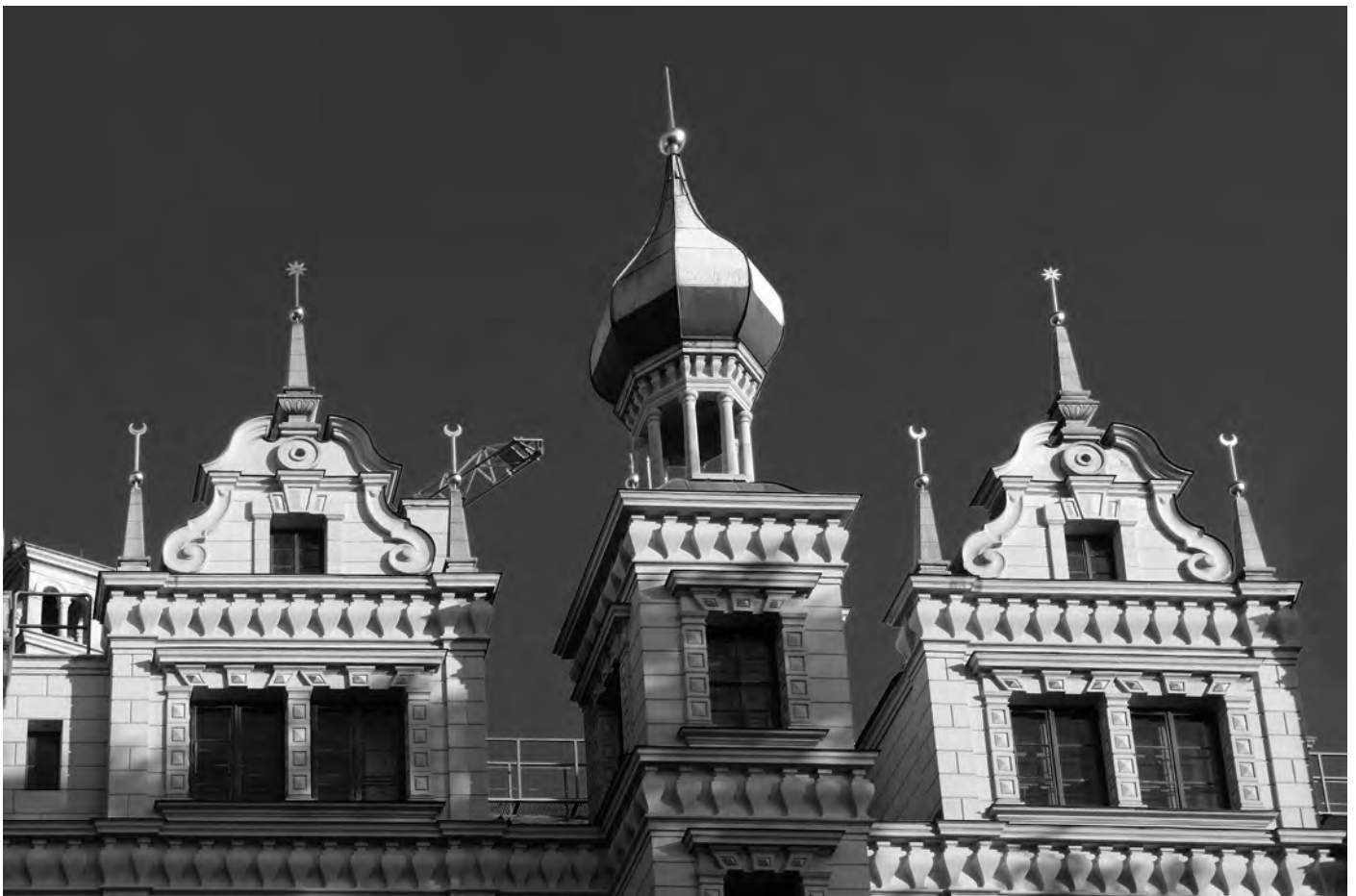
Landtag MV tut gut Baustelle 2016
